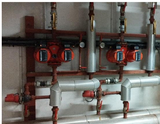
Pompes de circulation A5, A4 et A3 (de gauche à droite)
