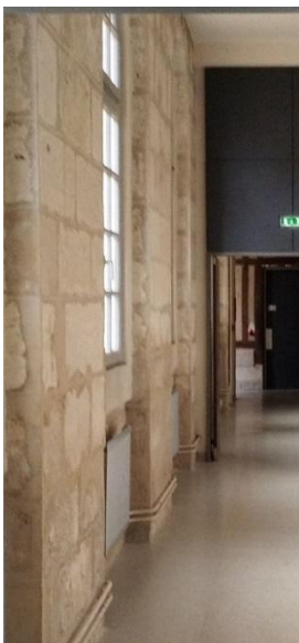
Mur en pierre et plancher bas Terre-plein Couloir – RDC bâtiment A
