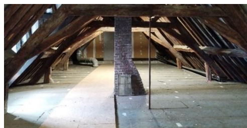
Isolation panneaux en verre cellulaire 15 cm – combles bâtiment E
