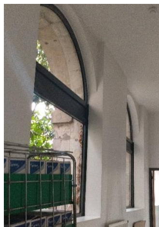
Menuiseries métalliques simple vitrage RDC bâtiment C
