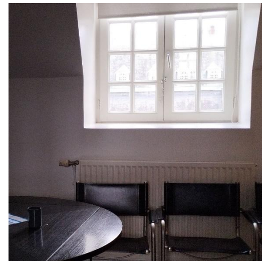
Toiture/murs rampants et menuiseries bois simple vitrage - Bureau R+2 bâtiment C
