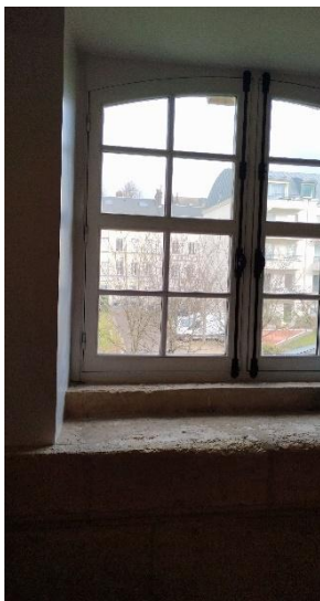
Mur en pierre + menuiserie bois double vitrage Bureau R+2 bâtiment D
