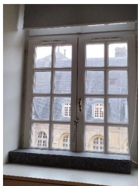
Menuiseries bois simple vitrage + entrées d'air – R+2 bâtiment B
