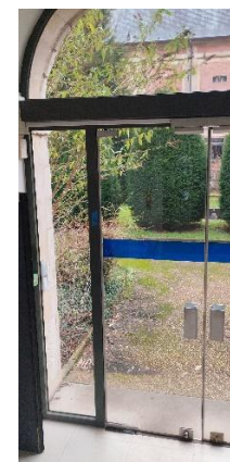
Porte métallique simple vitrage non étanche à l'air – RDC bâtiment C
