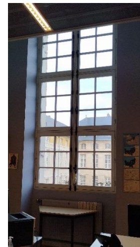
Menuiseries bois double vitrage – R+1 bâtiment E
