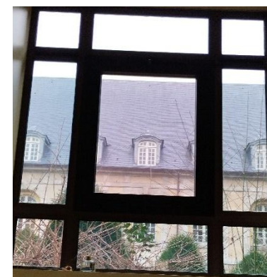
Menuiseries métallique double vitrage blindé – RDC bâtiment B
