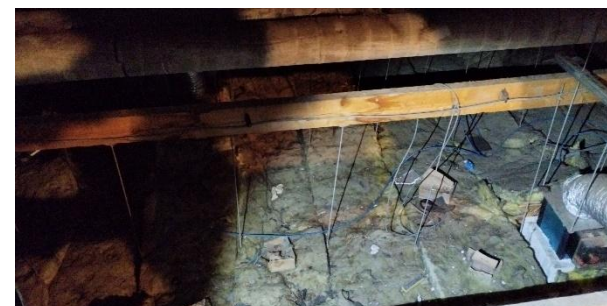
30 cm de laine de roche dégradée - Combles bâtiment central
