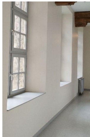
Sol terre-plein + menuiseries bois simple vitrage - Couloir RDC jonction bâtiment E à central
