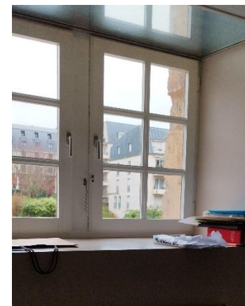
Menuiserie bois simple vitrage – R+1 et mezzanine bâtiment central
