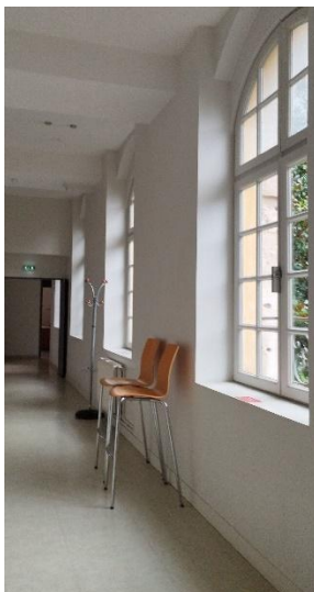
Mur Pierre + doublage Couloir R+1 bâtiment C
