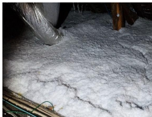
Ouate de cellulose soufflée par-dessus laine de roche existante (40cm en tout) – combles bâtiment D
