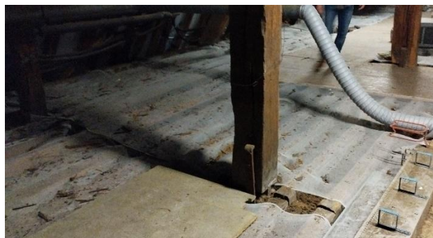
30 cm de laine de roche soufflée dégradée sous le voile - Combles bâtiment C
