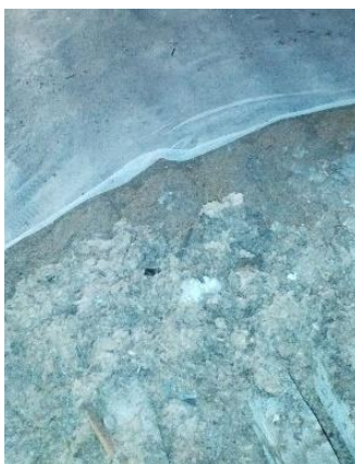
30 cm de laine de roche soufflée dégradée – combles bâtiment A
