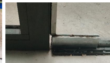
Porte métallique simple vitrage non étanche à l'air – RDC bâtiment C
