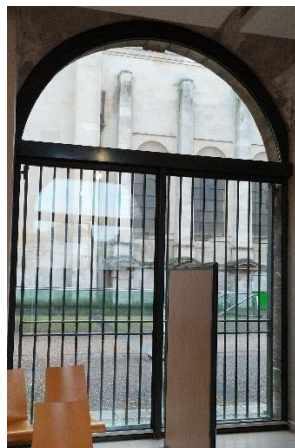
Menuiserie métallique simple vitrage – RDC bâtiment central
