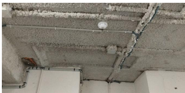
Flocage coupe-feu – plafond local GTB sous-sol bâtiment central
